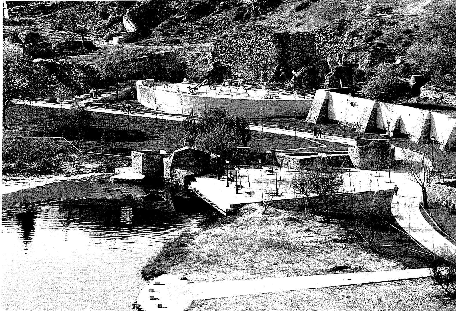
Vista parcial de la actuación realizada en la Zona 4.
