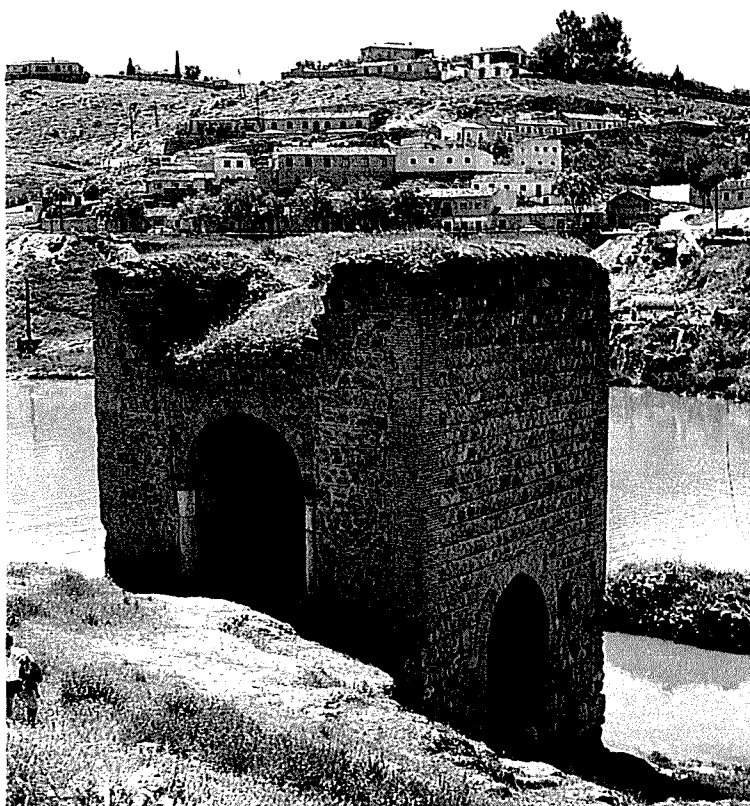
Puertas principal y lateral derecha, antes de restaurarlas.
