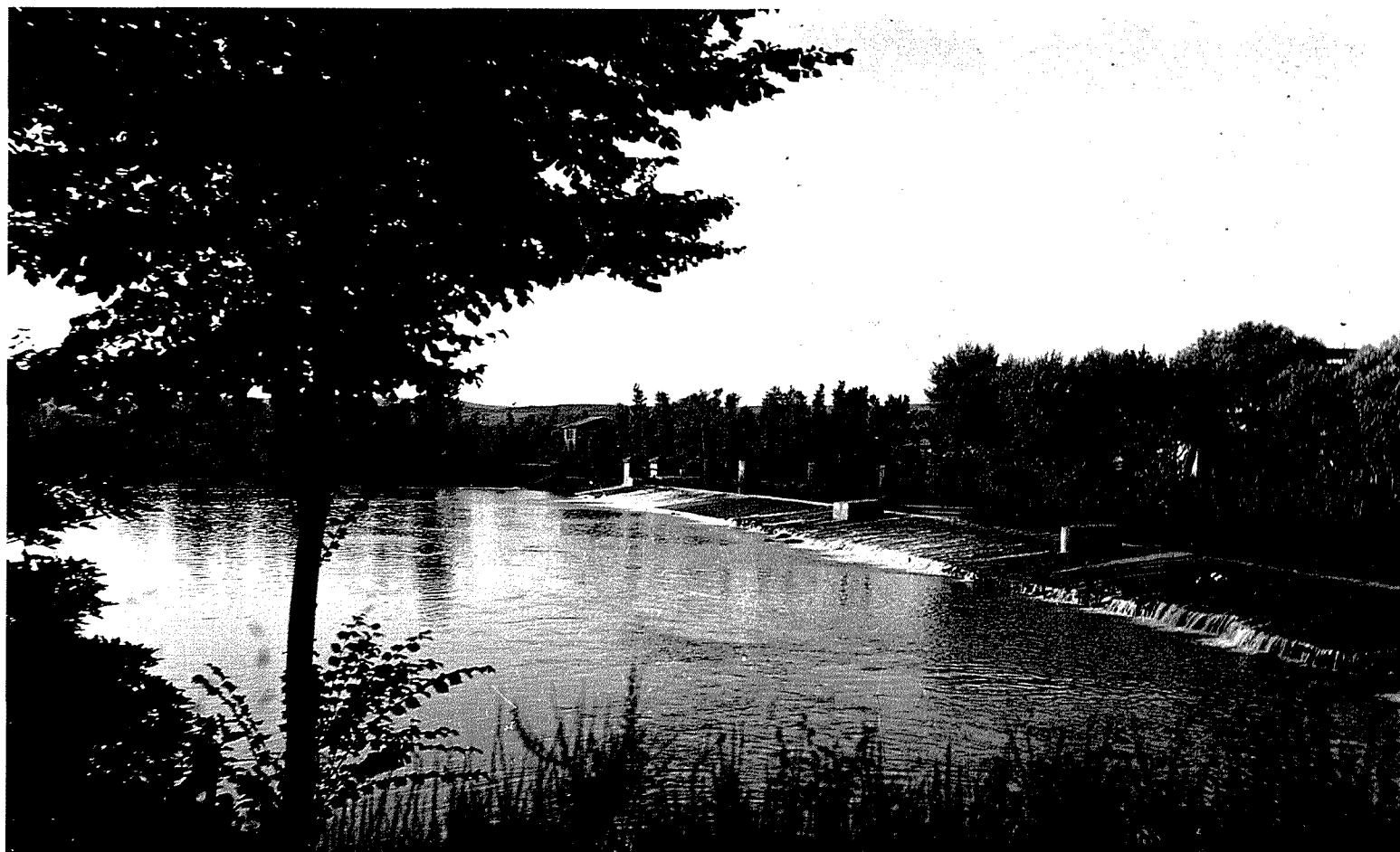
Presa en el río junto a la Fábrica de Armas.
