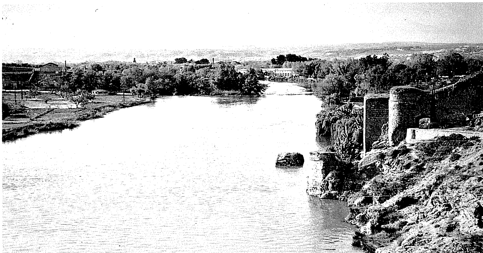
El Baño y la pila volcada, antes de construirse el nuevo puente.
