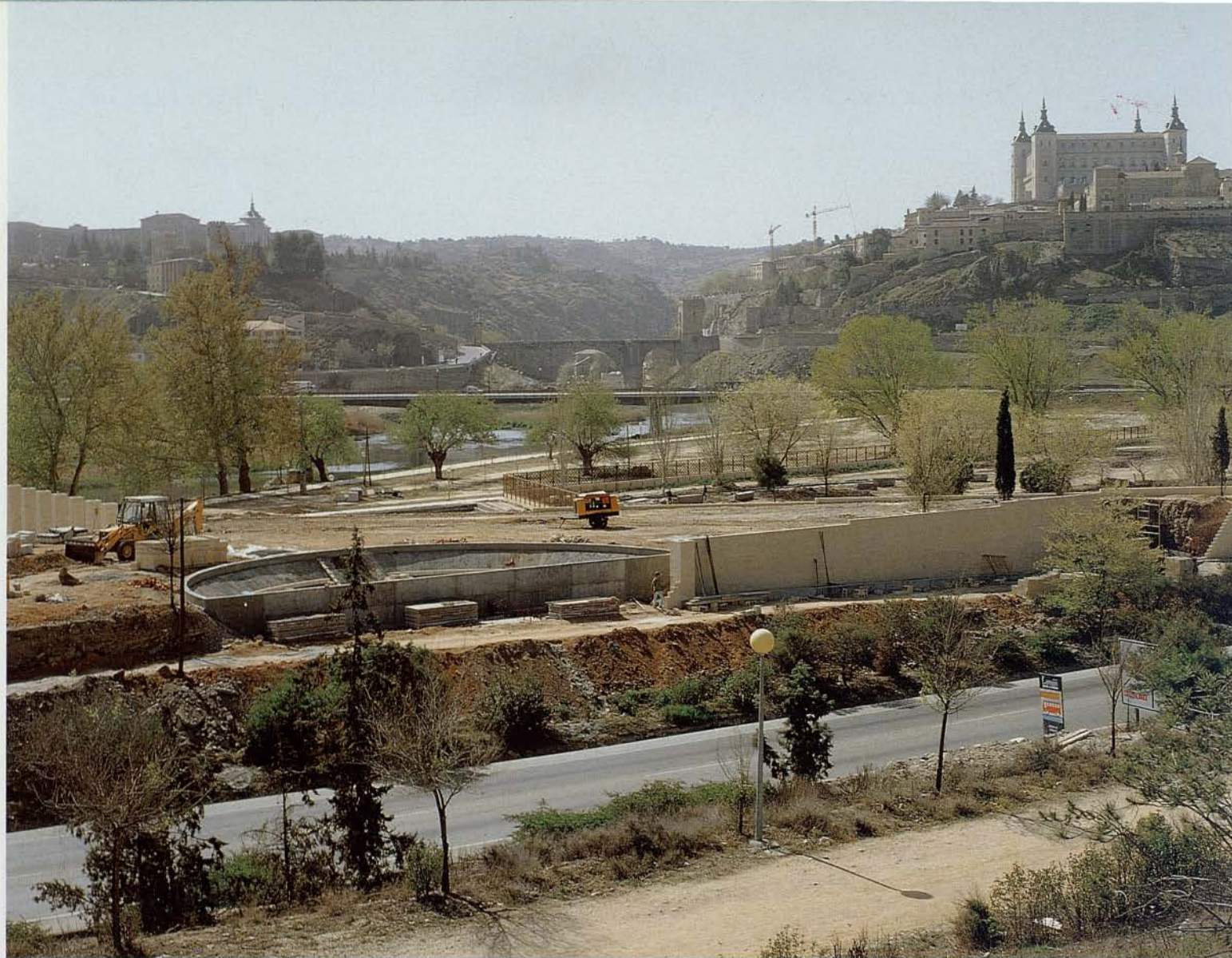
Vista general de las obras en la zona de la ribera norte. Foto: J. M. Moreno
