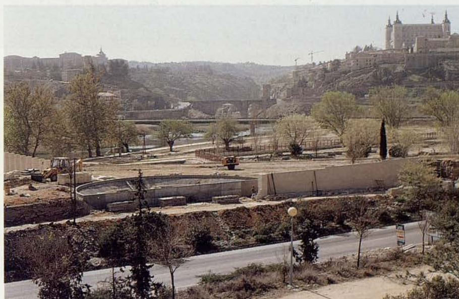
Arriba, axonométrica del Parque de Safort e imágenes de la noria antes de su instalación y de las obras que se llevan a cabo
