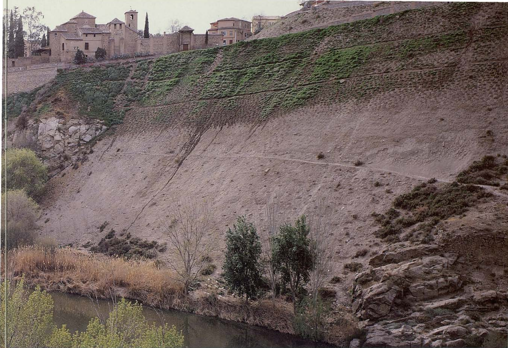
Panorámica de los rodaderos del río Tajo una vez concluidas las operaciones de limpieza y desescombro Foto: J. M. Moreno
