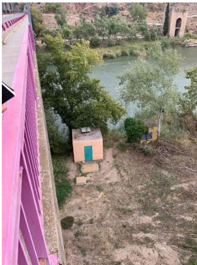
Caseta de instalaciones bajo el puente de la Cava
