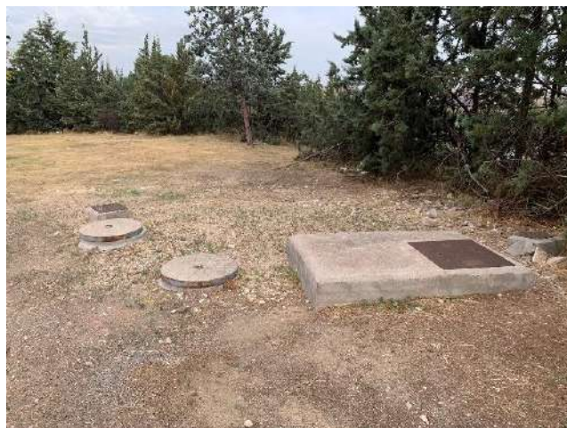
Registros de agua, saneamiento y gas en el espacio libre existente entre el borde oeste del ámbito, el puente de la Cava y la Carretera de Navalpino
