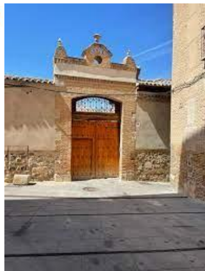
Fachada Calle San Clemente
