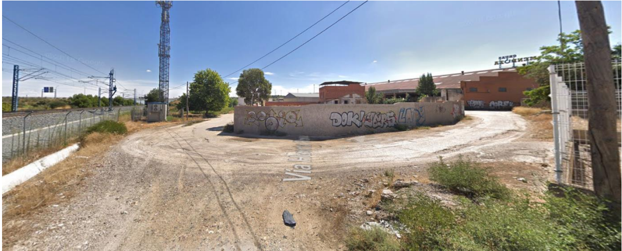
Figura 22. Naves situadas en la UA – 100 Este vistas desde el extremo noroeste. Fuente: Google.
