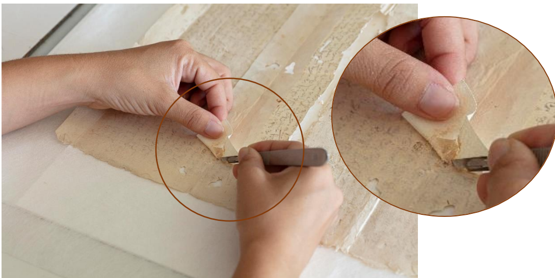
Figura 5. Eliminación de las antiguas reparaciones mediante bisturí
