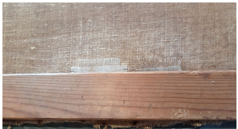
Colocación de parches
