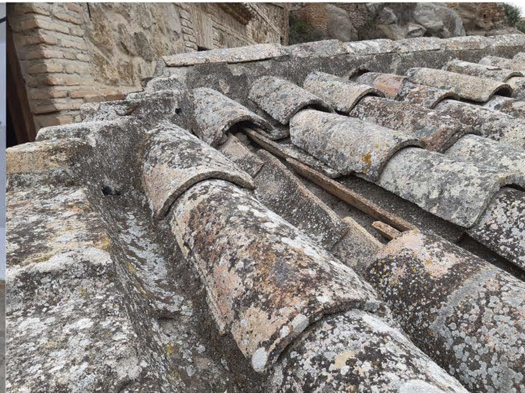
Falta de mantenimiento
