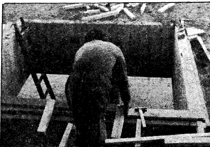
Los trabajos de acondicionamiento se realizan durante estos días
