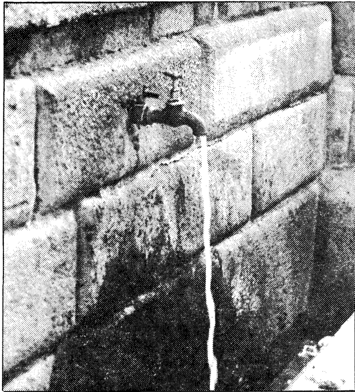
Los cortes intermitentes del agua sufridos por Madridejos y otros pueblos de la provincia impiden que se pueda dejar correr el agua, como en la imagen de la fotografía
