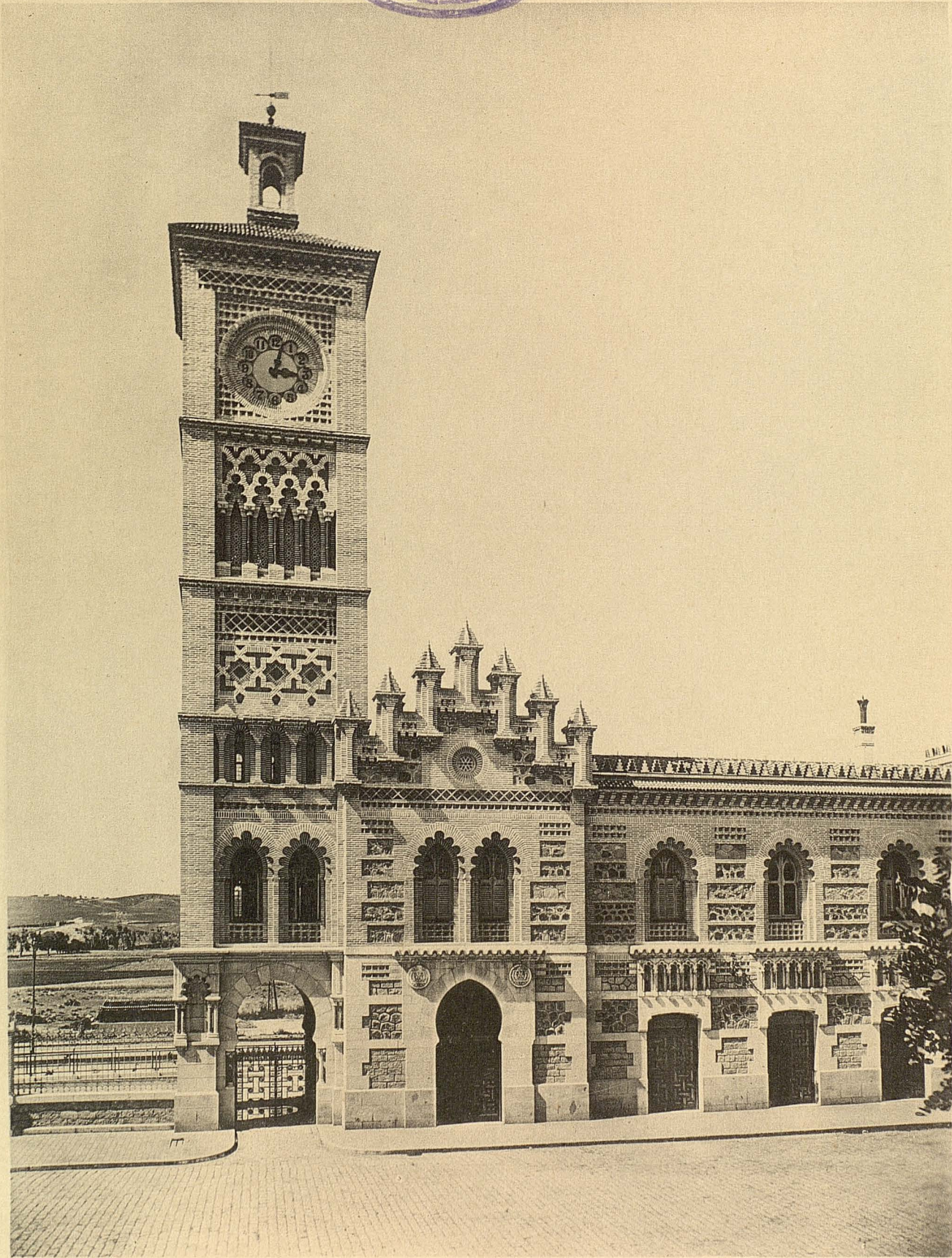
DETALLE DE LA FACHADA PRINCIPAL
