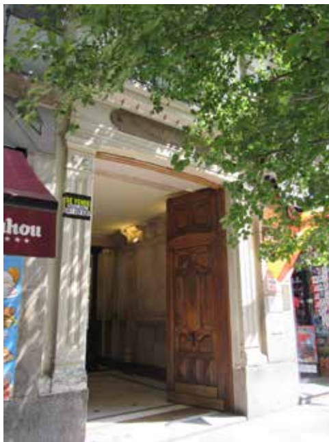
Portada del edificio de la calle Arenal 26, sede de la Casa de Toledo en 1931
