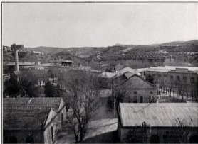
Vista parcial de la Fábrica.
