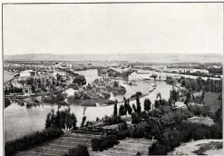
Vista general de la Fábrica desde la Puerta del Carbón.
