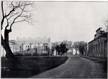
Vista parcial de la Fábrica.
