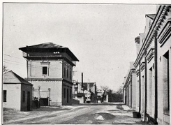
Central de gas.
