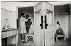
Cartuchería. Cabinas para la obtención del fulminato de mercurio.
