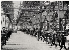
Espoletas. Vista parcial del taller de construcción.
