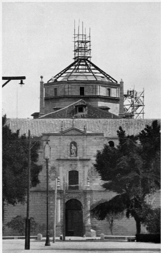
TOLEDO. — Hospital de Afoera, durante las obras de reconstrucción.
