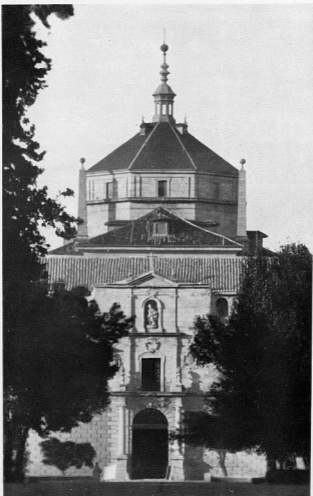
TOLEDO. — Hospital de Afuera, totalmente reconstruido.
