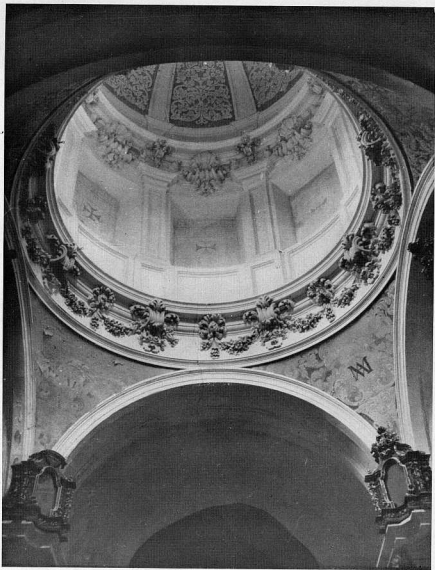
TOLEDÓ.—Iglesia de San Marcos. Cúpula de la capilla lateral derecha. Conjunto.
