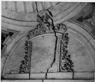
TOLEDO.—Iglesia de San Marcos. Capilla lateral. Detalle de una grieta.—Abajo: Andamio metálico en el Altar Mayor y cúpula central.
