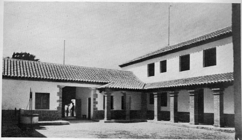
ARGÉS.—Casa-cuartel para la Guardia Civil. Patio y fachada principal.
