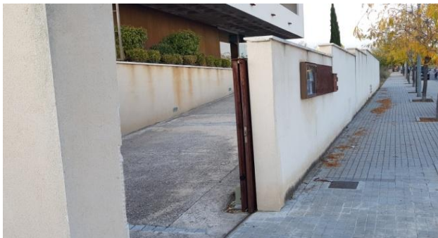
ESTADO ACTUAL CERRAMIENTO.
