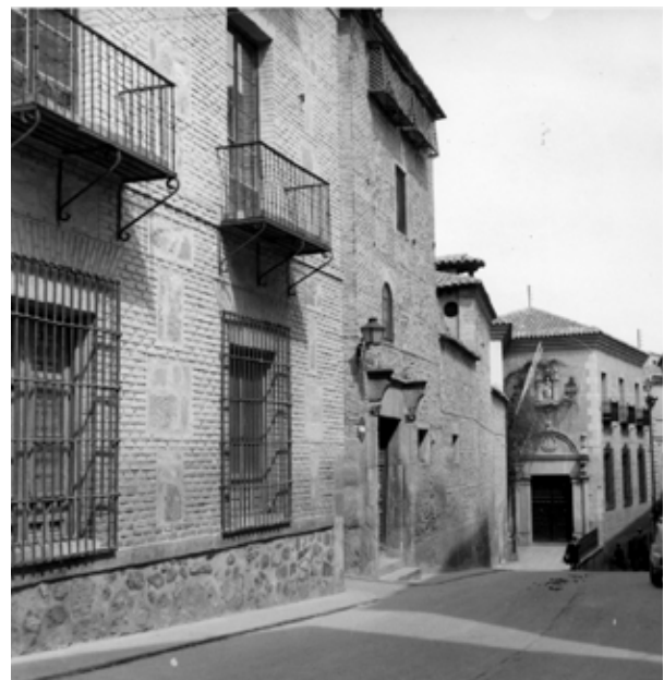
Calle Trinidad, hacia 1960. En primer plano, el edificio que se levanta donde estuvo la Casa de las Infantas; inmediatamente detrás, el Convento de Jesús y María, actual Archivo histórico Provincial (CT-092)
