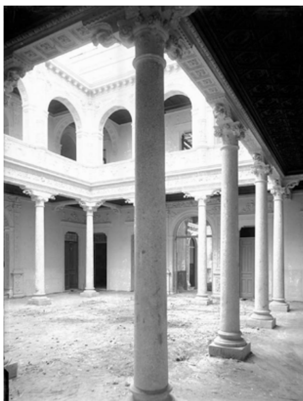
Aspecto del patio durante las obras del hotel. AMT. Foto Alguacil
