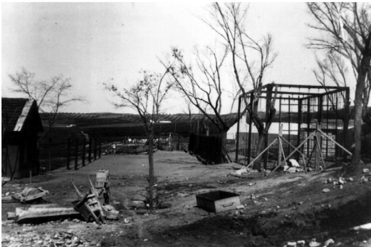
Primeros trabajos para construcción del gimnasio de la Escuela (Foto, Archivo ECEF)
