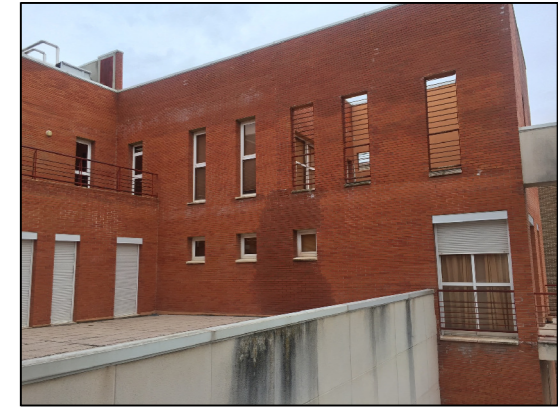
f02_ Humedad en fachada
