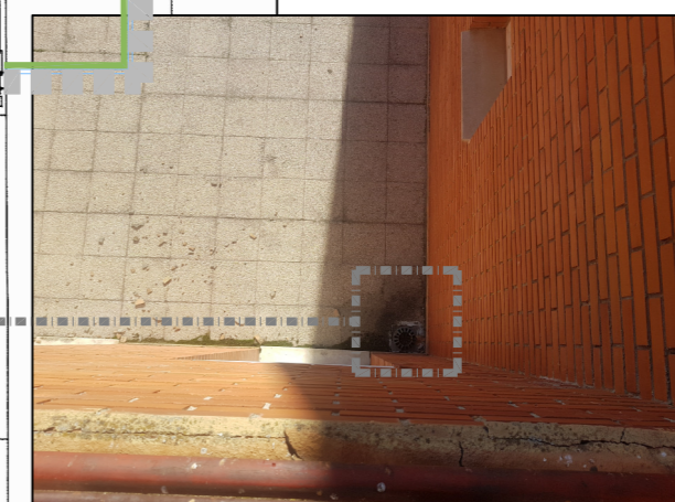
s_03: Sumidero de la terraza que provocan humedad en la zona del salón de actos.
