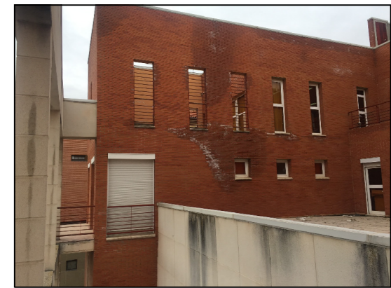
f01_ Humedad en fachada
