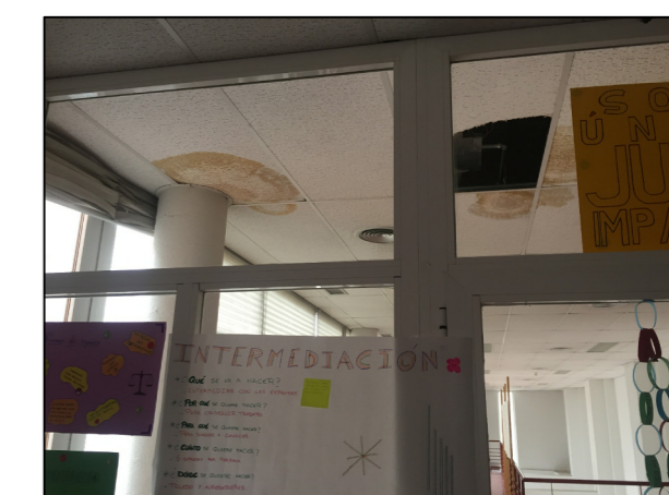
02_03: zona común planta primera. Humedad debida posiblemente a desagües de climatización
