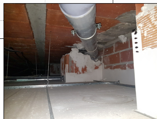
07: Humedad provocada por el sumidero de la terraza de la planta tercera y canalización a la bajante. (imagen interior de el falso techo)
