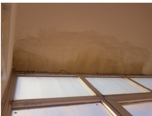
Interior núcleo de escaleras
