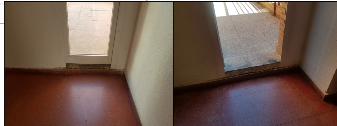
r_02/r_03/r_04: Humedad en los huecos de las puertas de acceso a las terrazas que provoca la separación del rodapié.
