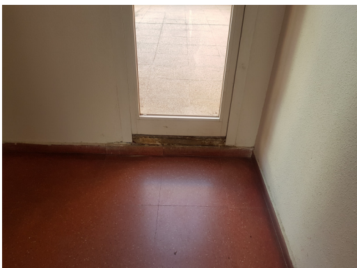
Falta de acabado interior en acceso a terraza planta tercera
