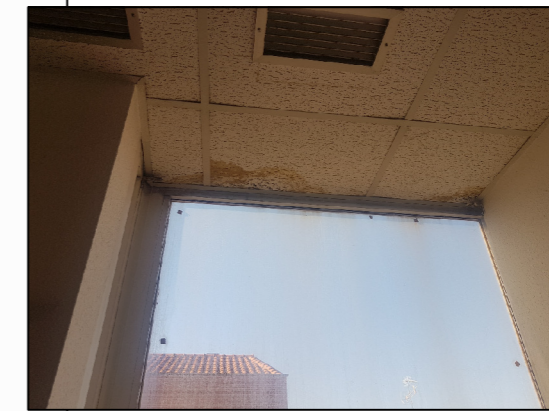
12_ Humedad sobre la carpintería exterior
