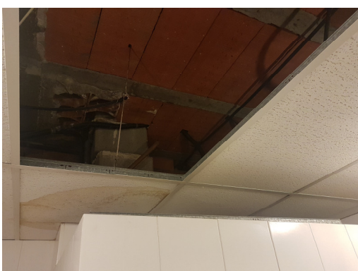
aseos de la plana tercera (origen de la humedad: cubierta)
