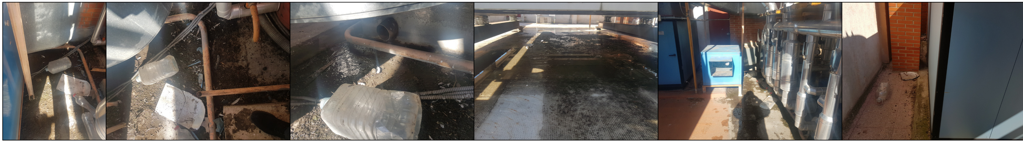
Suciedad en la zona de instalaciones de la cubierta
