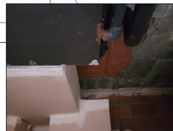
09: Desagüe del aparato de climatización por falso techo.
