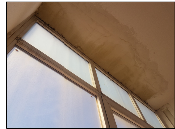
11_ Zona de las escaleras con humedad sobre la carpintería exterior.
