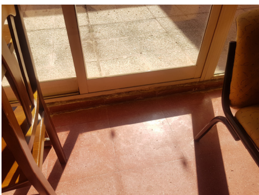
Humedad zona de rodapié.
