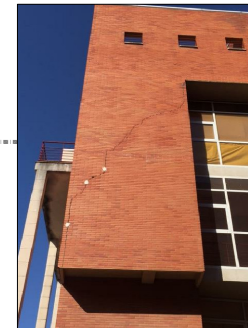
Fisura fachada Calle Alcántara
