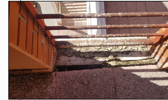
f1_ Balconeras de las terrazas de la planta segunda deterioradas. Posible origen humedad fachada
