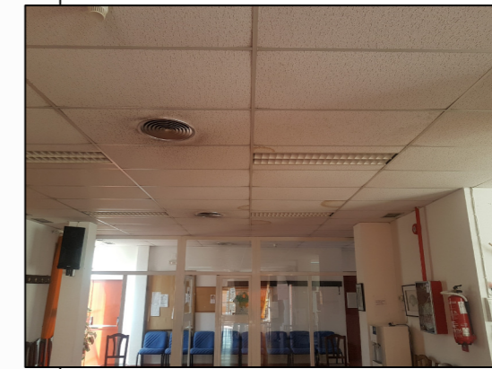
10_ "Club social" Zona afectada por la humedad posiblemente provocada por la cubierta de las instalaciones
