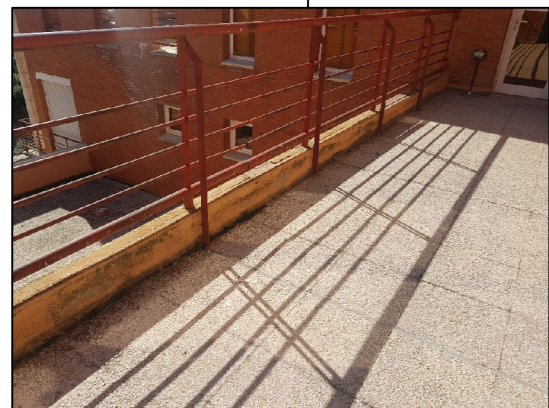
r_05: Humedad en el peño de fábrica de la barandilla de la terraza
