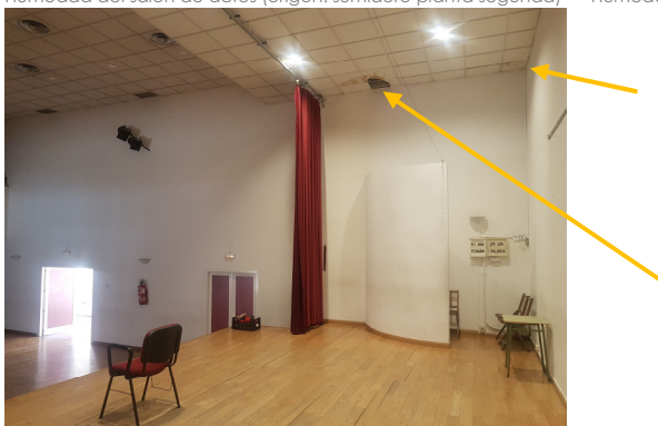
Humedad del salón de actos (origen: sumidero planta segunda)
