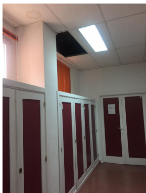
Humedad en pasillo distribuidor de la planta segunda. (origen: sumidero terraza lateral planta tercera)
