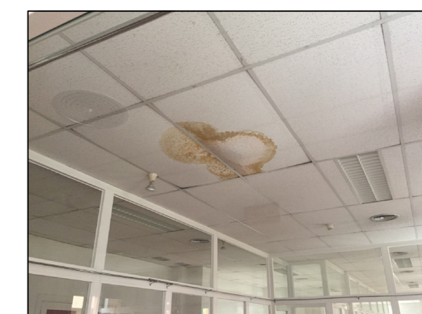
01_despacho planta primera. Humedad debida posiblemente a desagües de climatización
