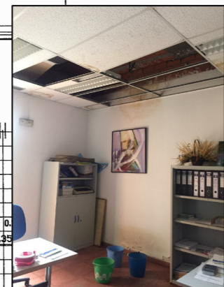
02_ Despacho del socio-animador. Humedad posiblemente provocada por la cubierta de las instalaciones
