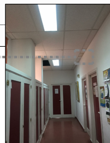
08: Humedad provocada posiblemente por desagüe de aparato climatización
