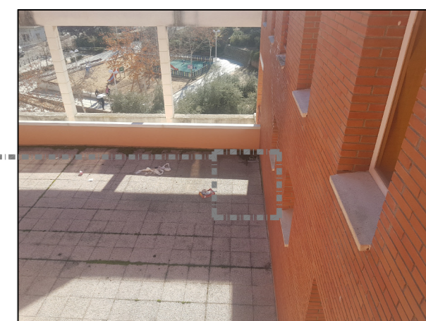
s_04: Sumidero de la terraza que provocan humedad en la zona del salón de actos.
