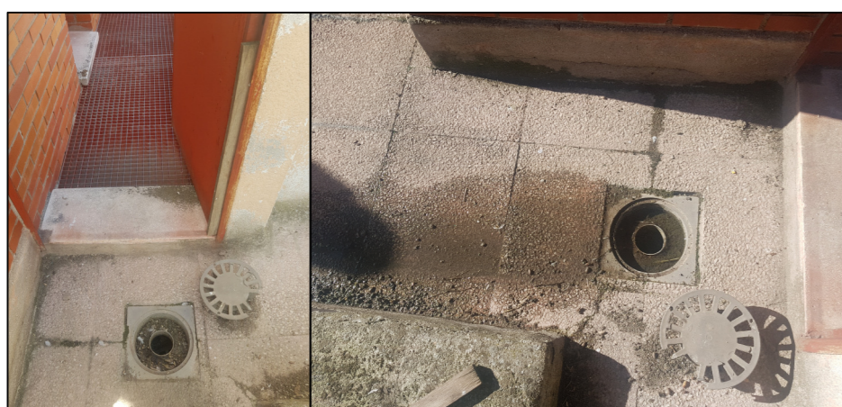
s_01: Sumidero de la terraza que provocan humedad en la planta tercera
