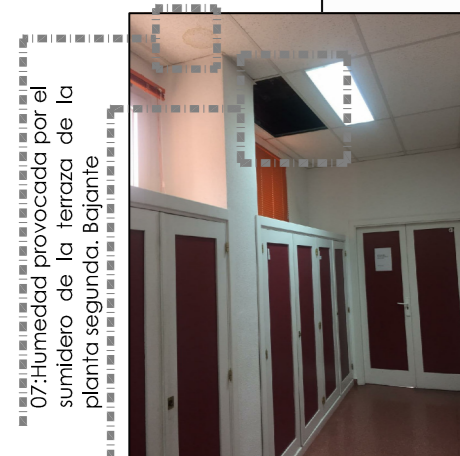
05: humedad de la biblioteca provocada por el sumidero 01 de la planta tercera.(ver plano 04)
