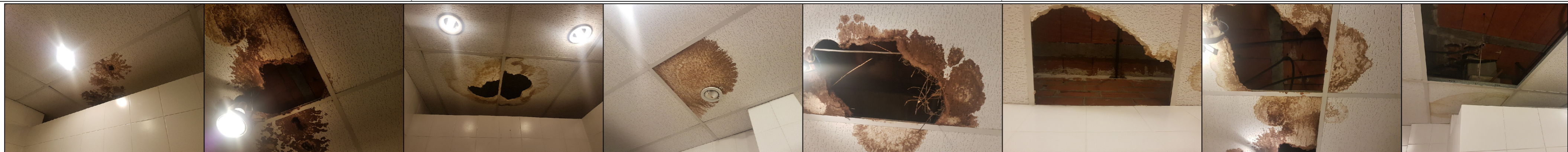
03/04/05/06/07/08/09: Zona de los aseos de la planta tercera afectada por la humedad posiblemente provocada por sumidero en mal estado y desagüe de aparatos de climatización
