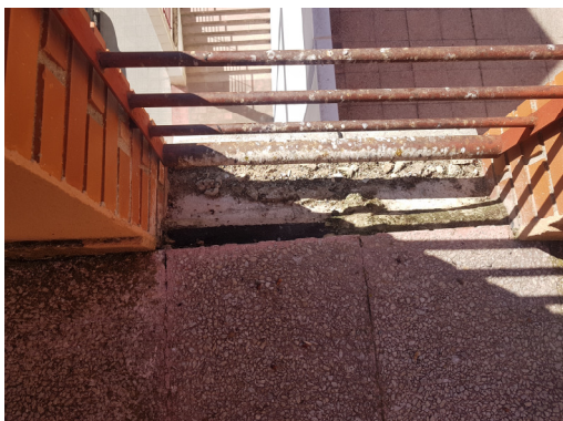
Hueco sin vierteaguas de una de las terrazas de la planta tercera
