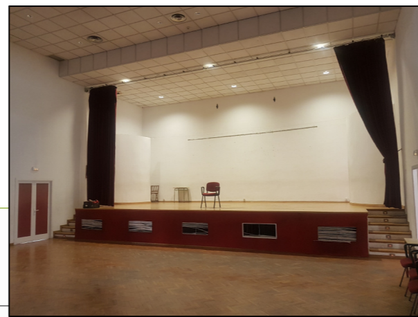
Salón de actos: Rejillas de climatización dañadas
