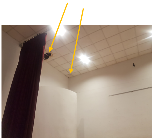
Humedad del salón de actos (origen: sumidero planta segunda)
