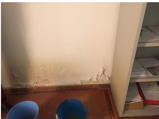
Despacho del socio-animador. Humedades en la pared debido a las salpicaduras del agua del techo.
