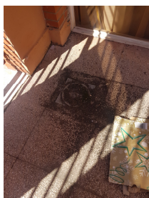
Sumidero terraza planta tercera
