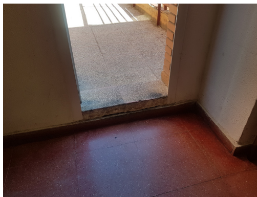
Falta de acabado interior en acceso a terraza planta tercera
