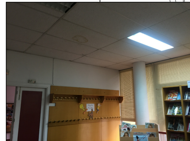
10: humedad de la biblioteca provocada posiblemente por el desagüe de los aparatos de climatización.
