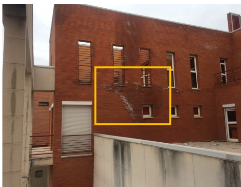
Fachada interior edificio Calle Ciudadano
