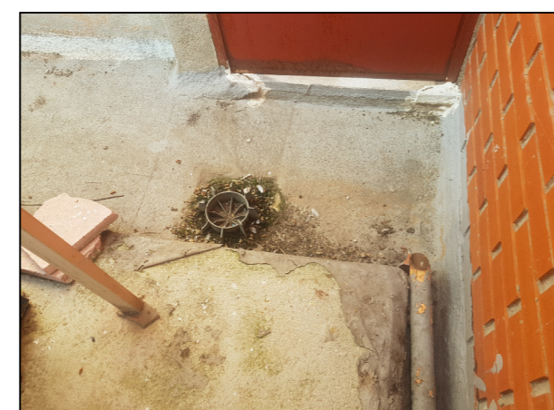
s_02: Sumidero de la terraza que provocan humedad en la planta tercera
