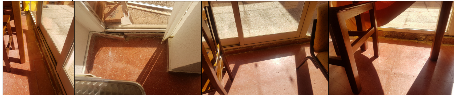
r_01: Humedad en la parte interior de la carpintería exterior que está junto a las terrazas que provoca la separación de los rodapiés.
