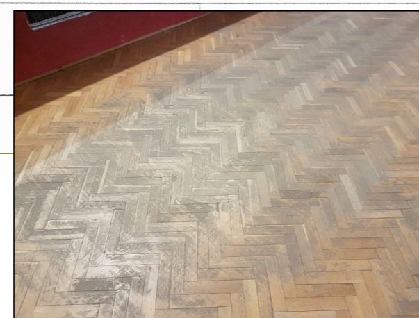
Salón de actos: Solado de madera deteriorado
