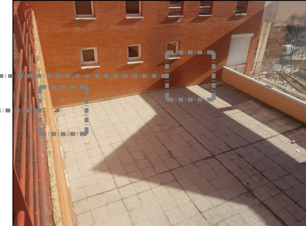
s_01: Sumidero de la terraza que provocan humedad en la zona del salón de actos. s_02: Sumidero de la terraza que provocan humedad en la zona del salón de actos.
