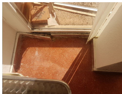
Desprendimiento de rodapié.
