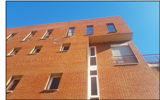
f04_ Humedad en fachada
