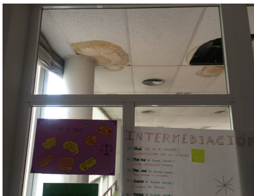
Zona común de la planta primera
