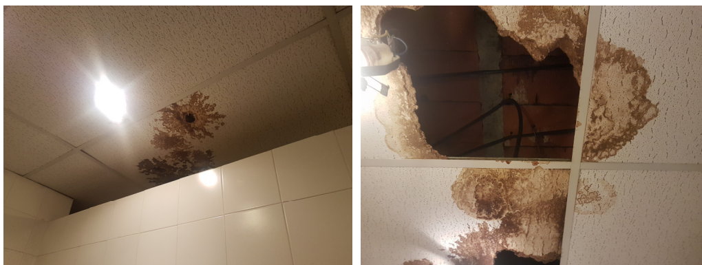
aseos de la plana tercera (origen de la humedad: cubierta)
