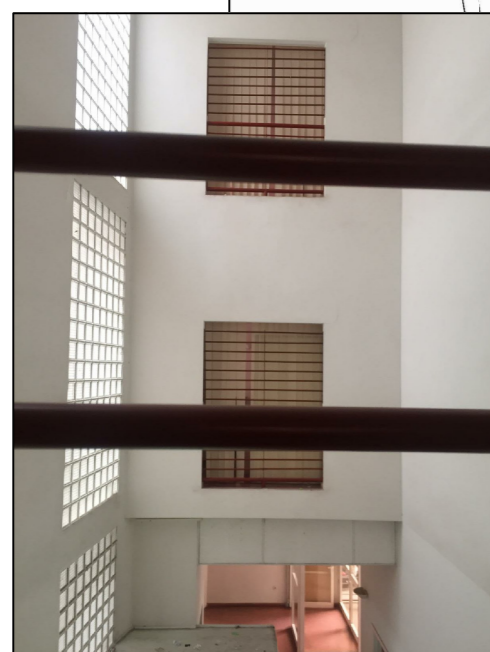
huecos abiertos al vestíbulo principal
