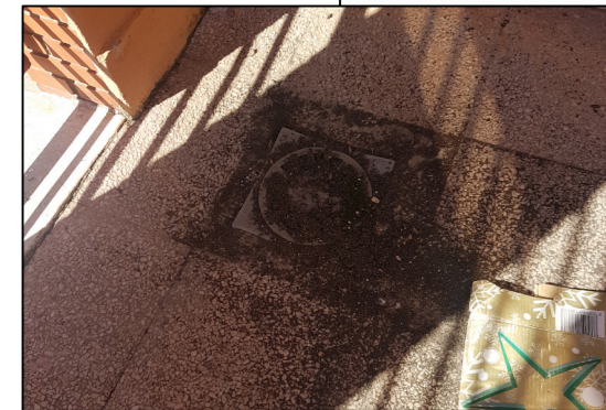
s_01: Sumidero de la terraza que provoca humedad a la zona de la biblioteca de la planta segunda.
