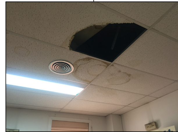
10: humedad de la biblioteca provocada posiblemente por el desagüe de los aparatos de climatización.
