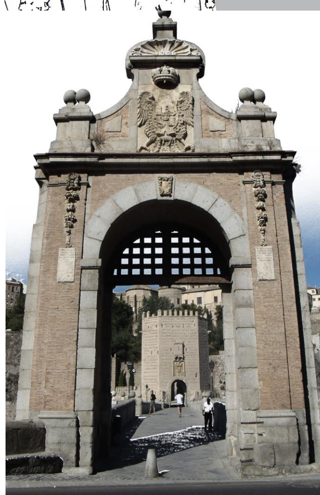
VISTA DE LA ENTRADA A LA PUERTA
