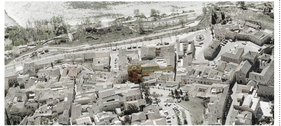
Vista aérea del conjunto
