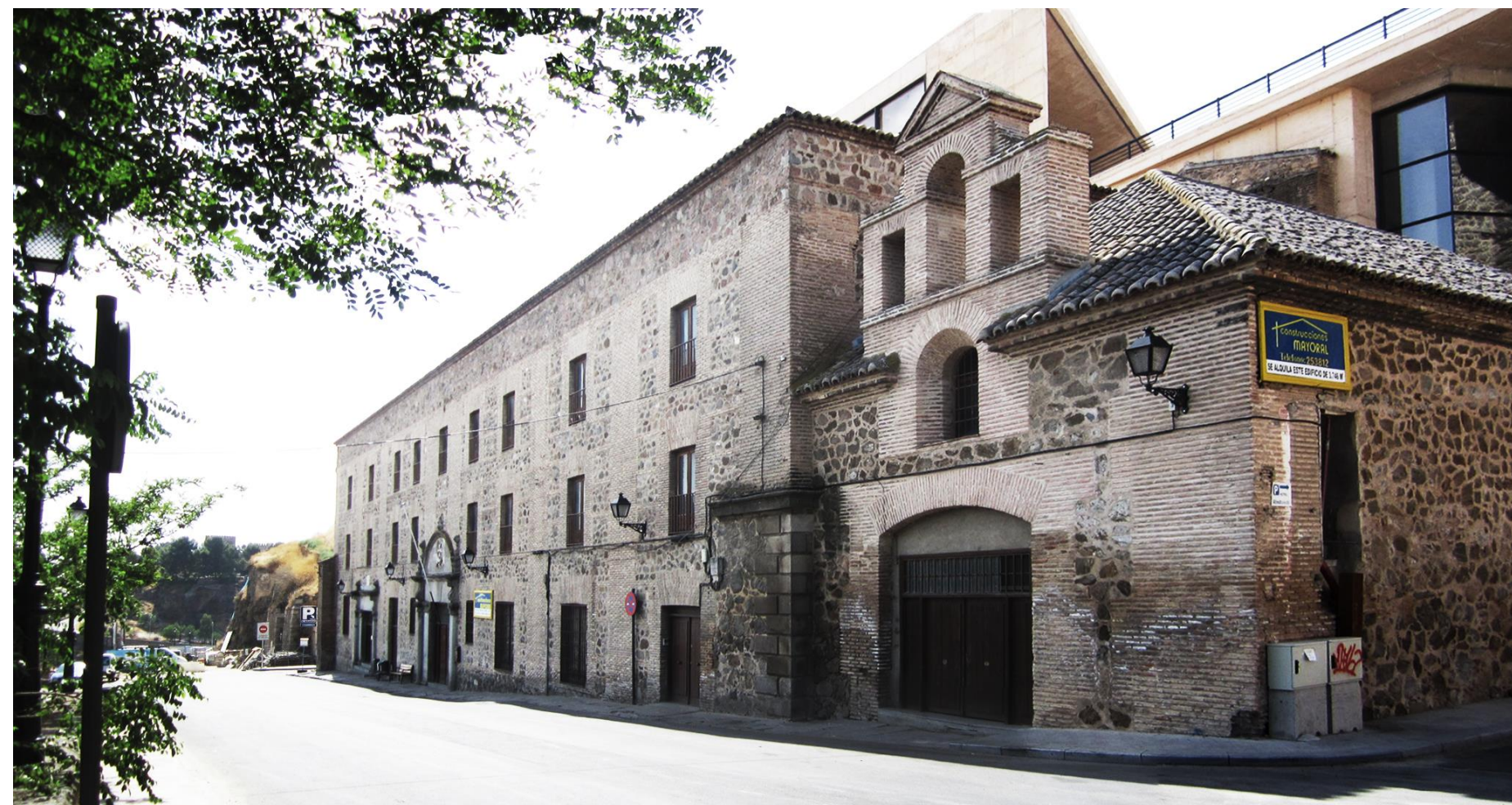
VISTA DE LA FACHADA PRINCIPAL
