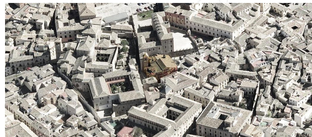
Vista aérea del conjunto
