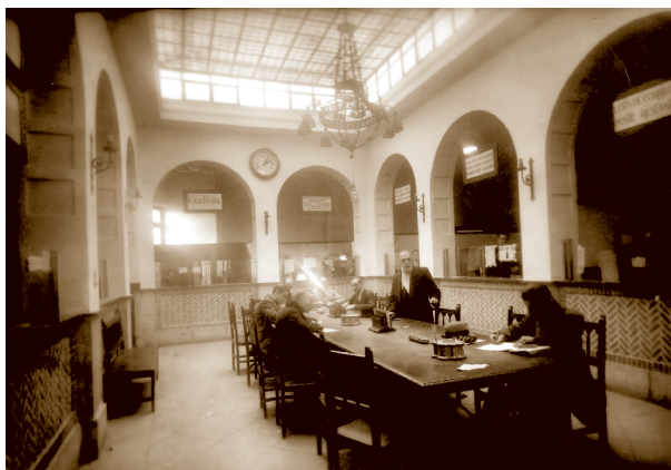
Patio de operaciones de la sede provincial de Correos, edificio inaugurado durante la jefatura desempeñada por Aguillaume en Toledo (Foto Rodríguez, AHPT)
