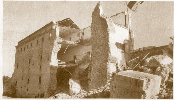
Núm. 12. Efectos de la primera mina en la fachada Oeste.
