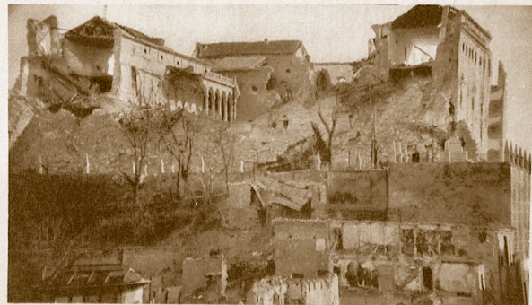
Núm. 11. Aspecto general de la fachada Norte.
