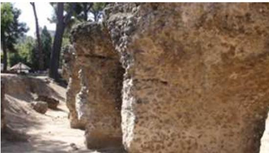
*Los revestimientos se han perdido. El opus caementicium está formado por fragmentos homométricos angulosos de piedra local. Las tongadas de cal constituyen vías preferentes de infiltración del agua.*
